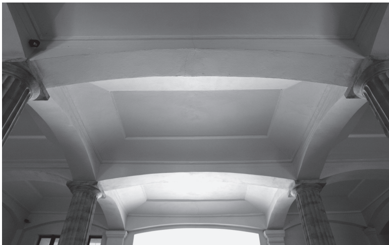
Obr. 3. Stropní konstrukce vstupu do velkého domu v Praze – Karlíně. Pomocí sloupů, velmi plochých segmentových pasů a ploch se zrcadlovými klenbami bylo možné vytvořit velmi vzdušný prostor. (Foto J. Škabrada)
